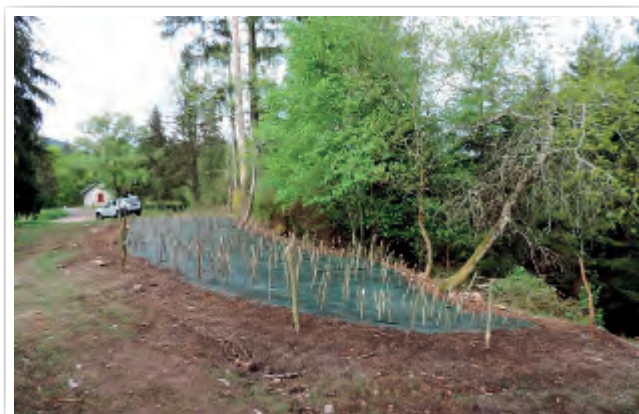
Aspect des travaux réalisés : bâche mise en place avec repiquage de saules pour créer rapidement une ambiance ombragée qui limitera la vigueur de la Renouée du Japon.
