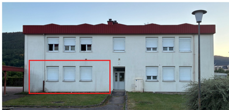
Locaux qui accueilleront l'ADMR et le SSIAD
