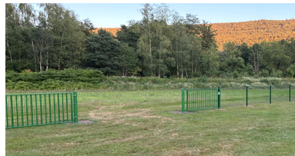
Mise en place d'une clôture pour fermer le site du Géhan
